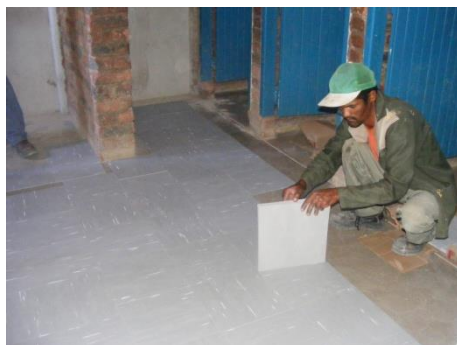
Teëls word installeer
